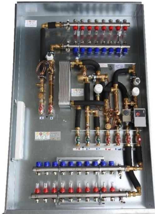
PM - FB-Heizung + Deckenkühlung
