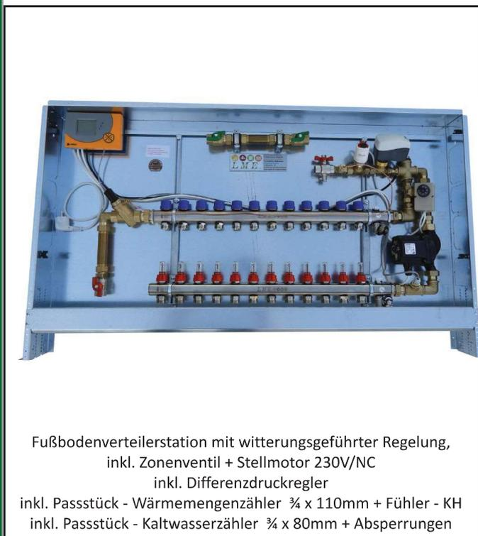
Fußbodenverteilerstation mit witterungsgeführter Regelung,
