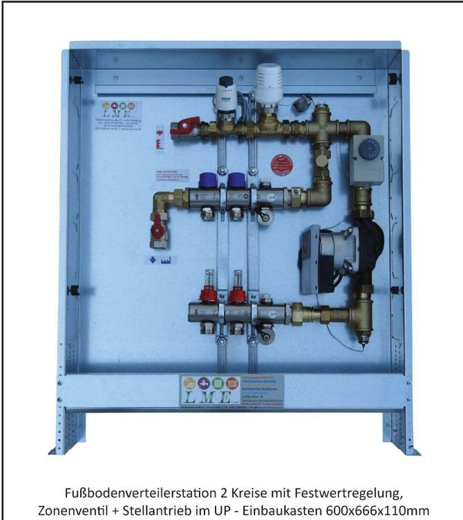
Fußbodenverteilerstation 2 Kreise mit Festwertregelung,
