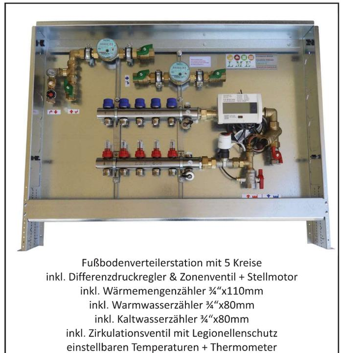
Fußbodenverteilerstation mit 5 Kreise
