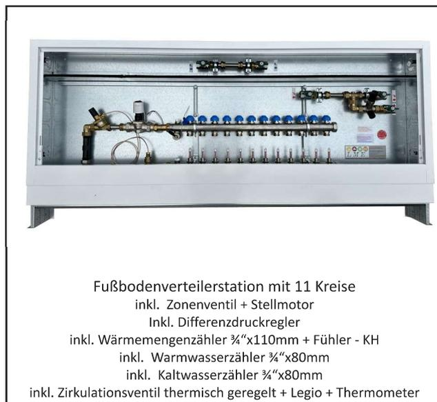
Fußbodenverteilerstation mit 11 Kreise
