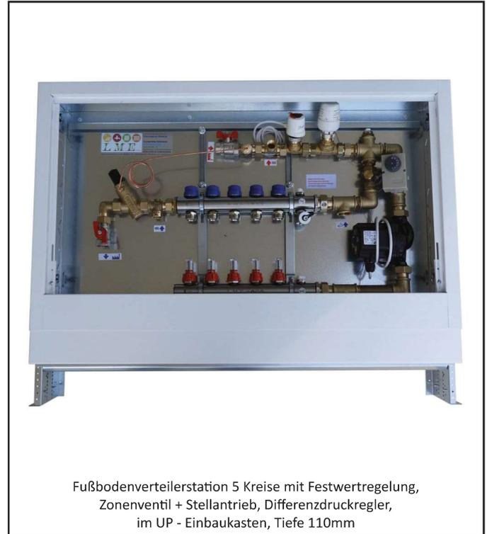
Fußbodenverteilerstation 5 Kreise mit Festwertregelung,
