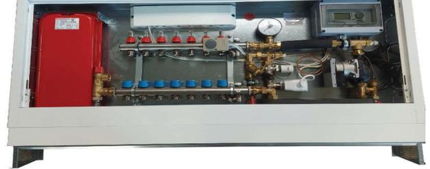
Fußbodenverteiler mit Systemtrennung
